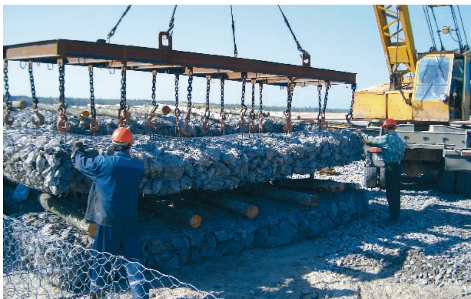
Габбионы – крепление дна в порту Усть-Луга
