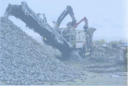
ГК «КрапМаш» при выполнении работ по демонтажу применяет экскаваторы-разрушители с вылетом стрелы от 9 до 40 метров, оборудованные гидравлическими ножницами, и мобильные дробильные комплексы для последующей переработки материалов, полученных в результате демонтажа. Материалы дробятся во вторичный щебень и кирпичную крошку и используются при работах науровного цикла в дальнейшем строительстве.
