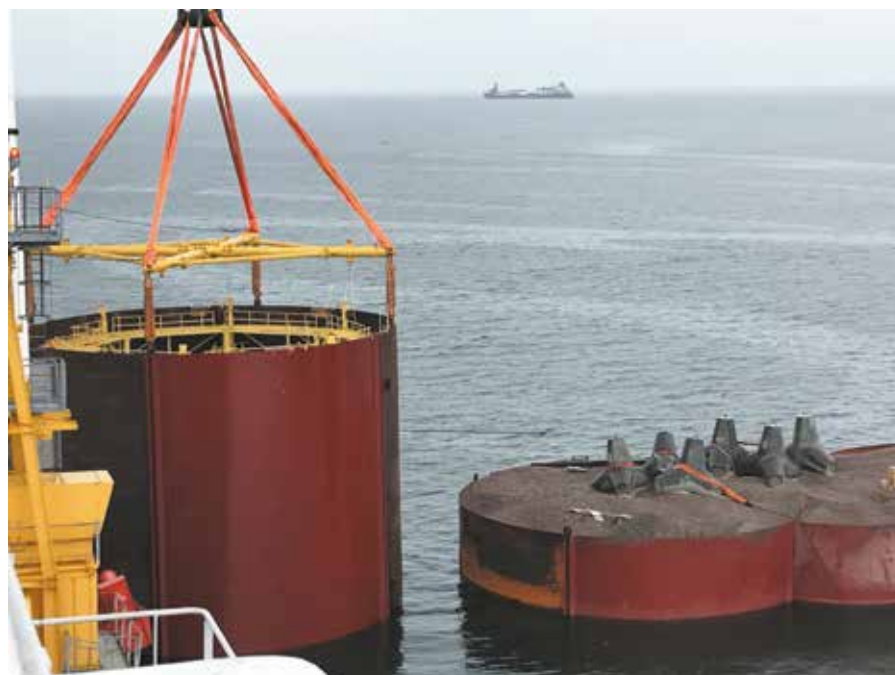
Рис. 3. Монтаж оболочек
