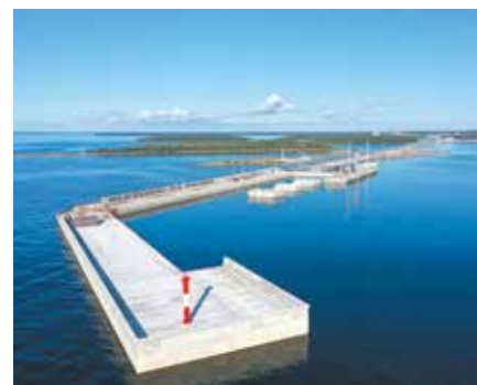
Рис. 6. Построенное сооружение. Фото: ООО «Газпром инвест»
